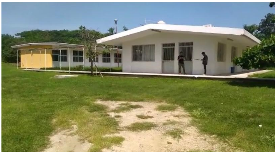
Figura 2. Toma de medidas en el bachillerato
